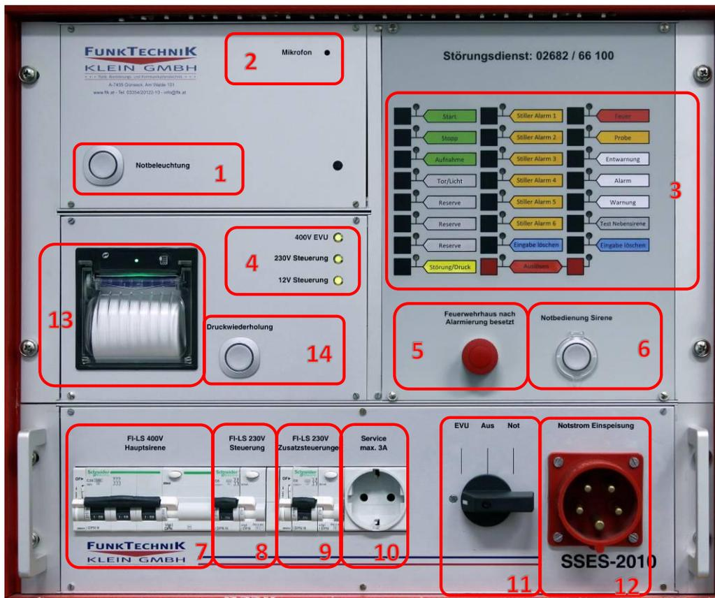
1. Notbeleuchtung - ermöglicht die Beleuchtung der SSES bei Stromausfall
